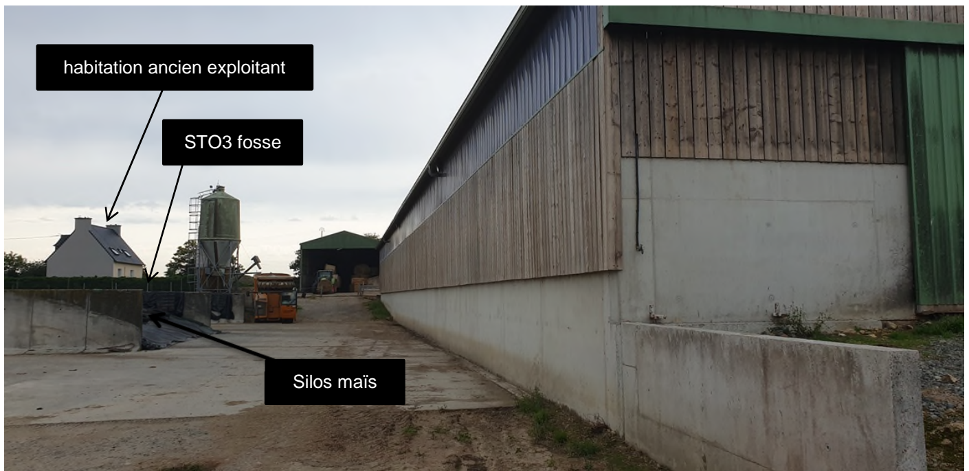
Vue de la façade sud
