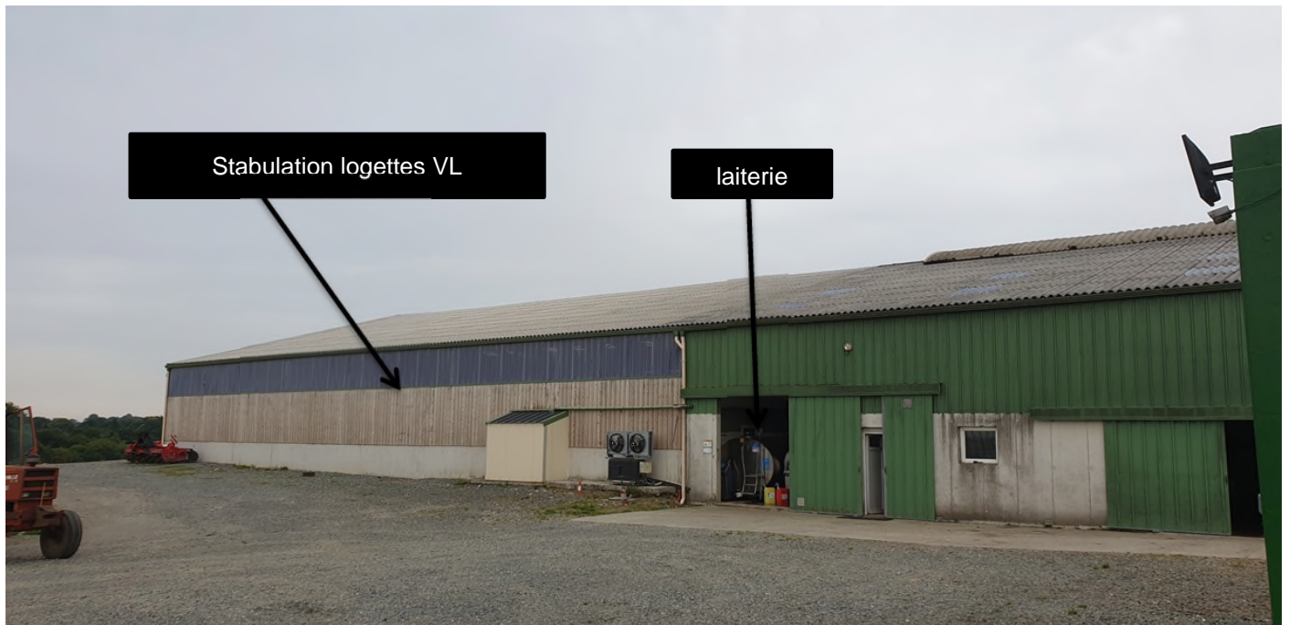
Vue de la façade nord de la stabulation vaches laitières
