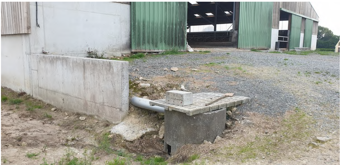
Vue du puits d'infiltration eaux pluviales
